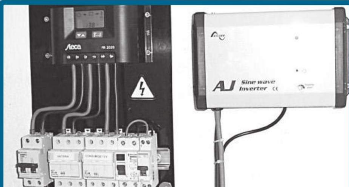
Paso 6: instalación de luminarias y equipos. Verificado el sistema con la batería a plena carga, se conectan los dispositivos.
