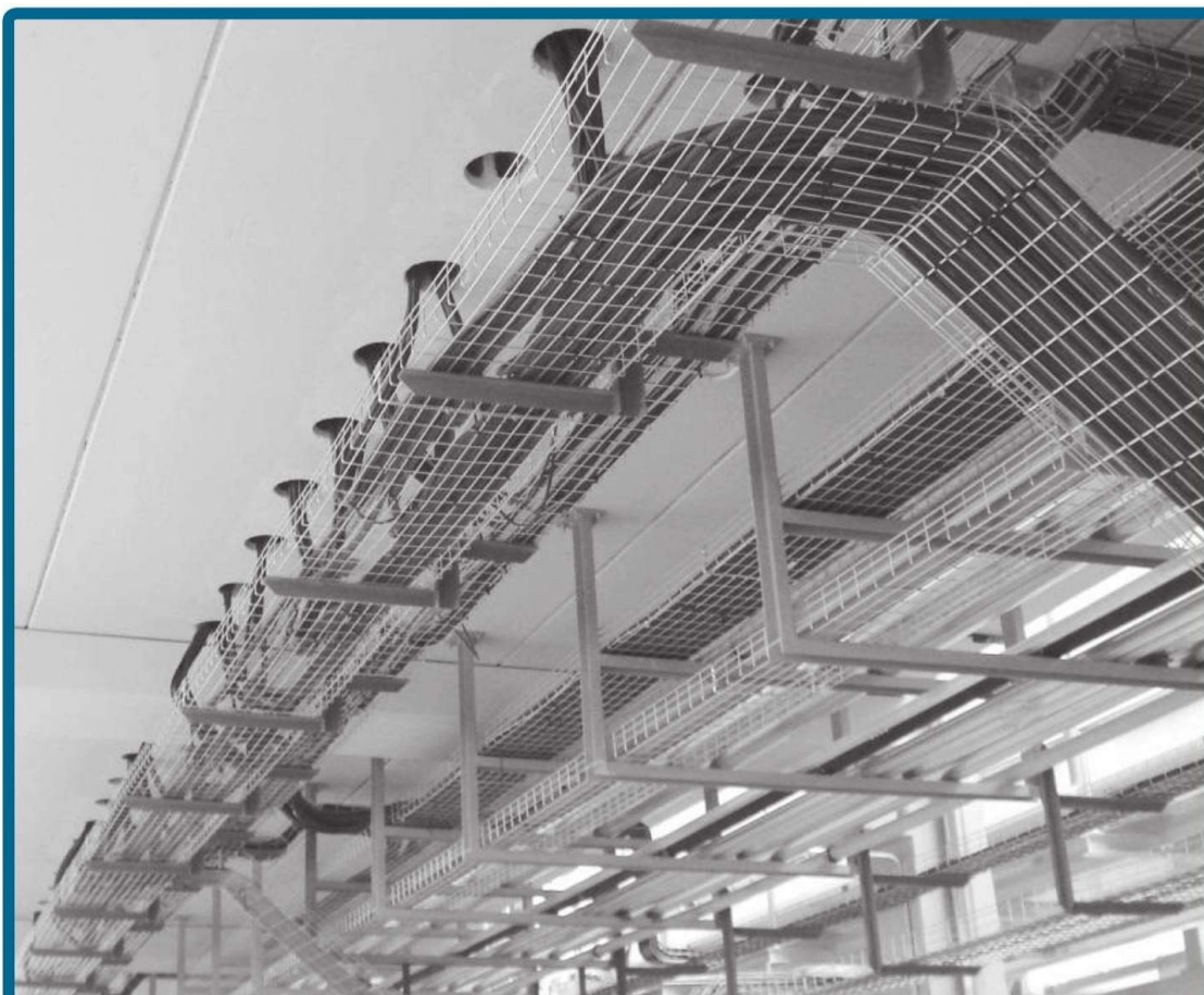
Canalizaciones aéreas en bandejas portables.
