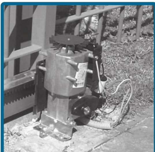
Detalle en la automatización de un portón corredizo donde se observa la ubicación de la carcasa del motor y parte de la cremallera.
